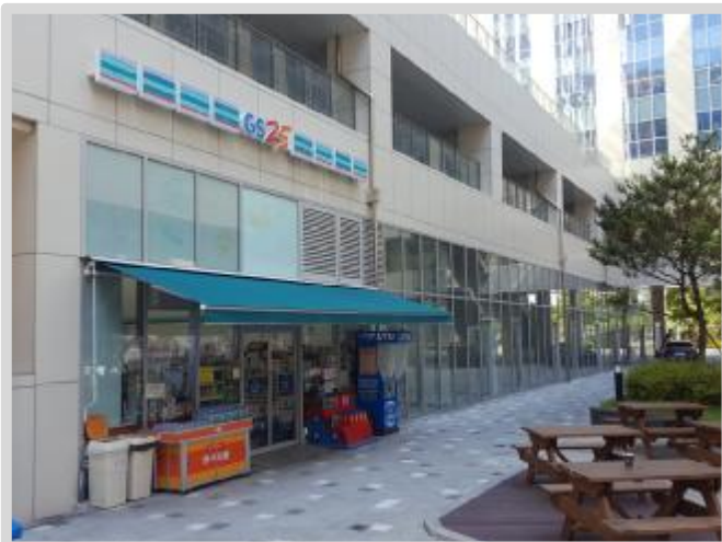
1층 내부 근린생활시설 등 전경 3
