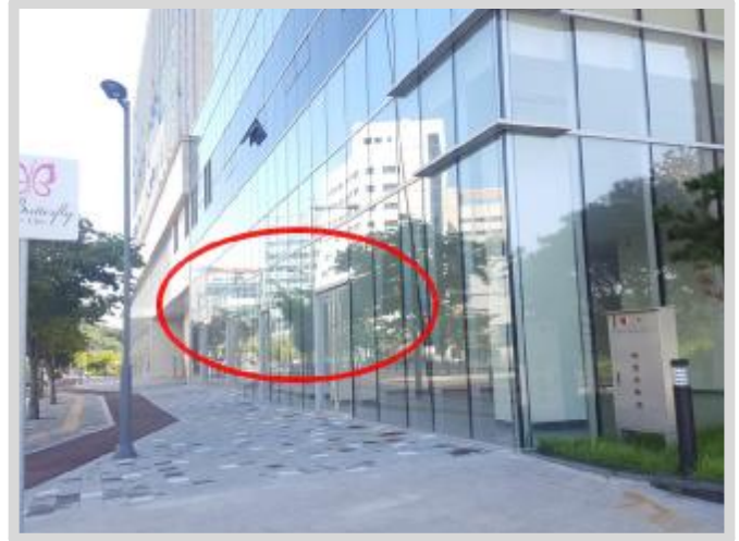
기호(1~4,13,15) 등 1층 북서측 전면 근린생활시설 전경 2
