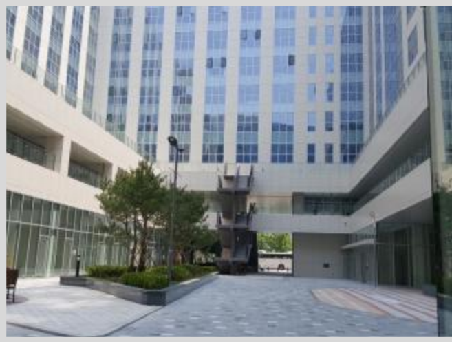
건물 중간부분 테라스 등 전경 1
