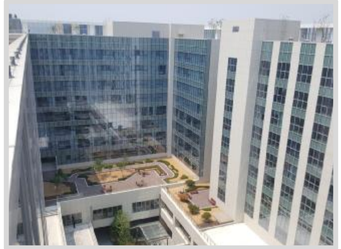
건물 중간부분 테라스 등 전경 2
