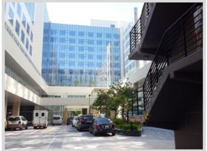
1층 내부 근린생활시설 등 전경 2
