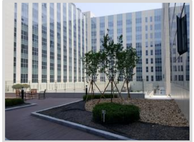
건물 중간부분 테라스 등 전경 4
