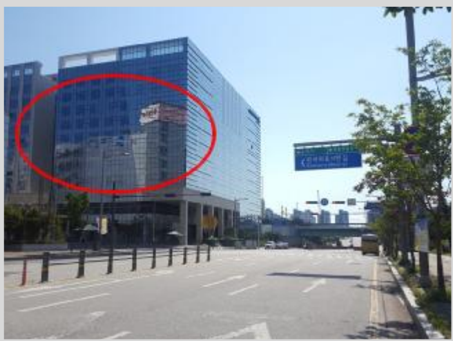
본 건 및 남서측 도로변 전경
