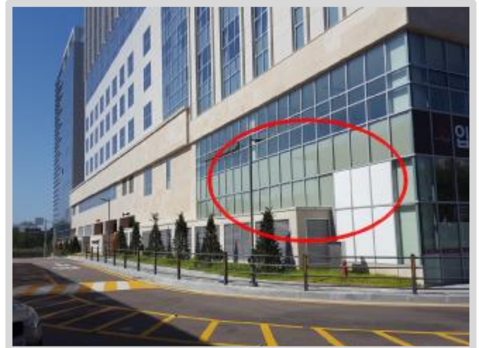
기호(20,21) 등 1층 북동측 전면 근린생활시설 전경 2
