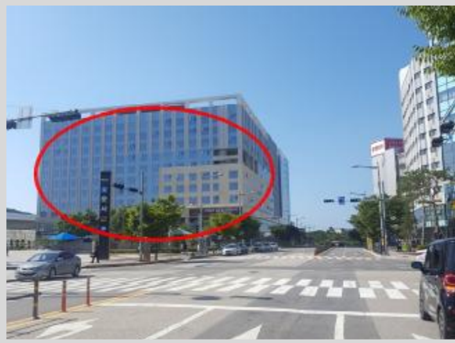
본 건 및 북서측 전면 전경 1
