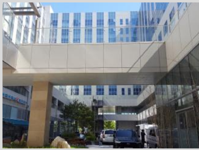
1층 내부 근린생활시설 등 전경 1
