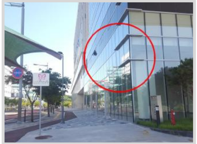
본 건 및 북서측 전면 전경 2
