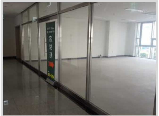
2층 내부 근린생활시설 등 전경 4
