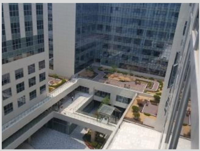
건물 중간부분 테라스 등 전경 3
