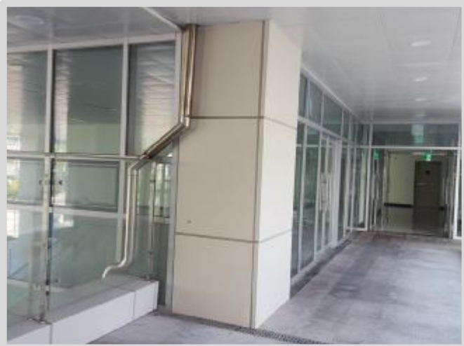
2층 내부 근린생활시설 등 전경 3
