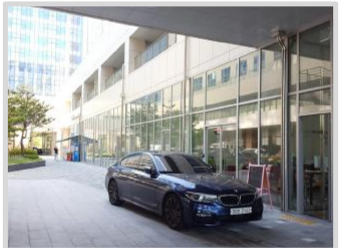
1층 내부 근린생활시설 등 전경 4
