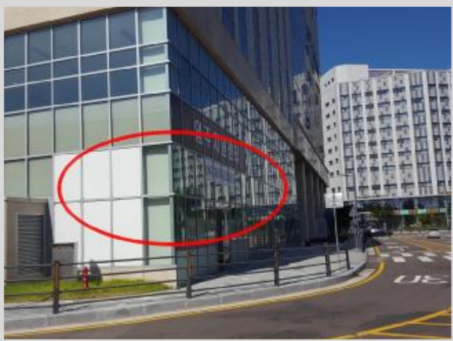
기호(20,21) 등 1층 북동측 전면 근린생활시설 전경 1
