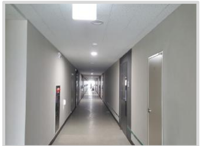
지웰오피스텔 내부 복도 등 전경 2
