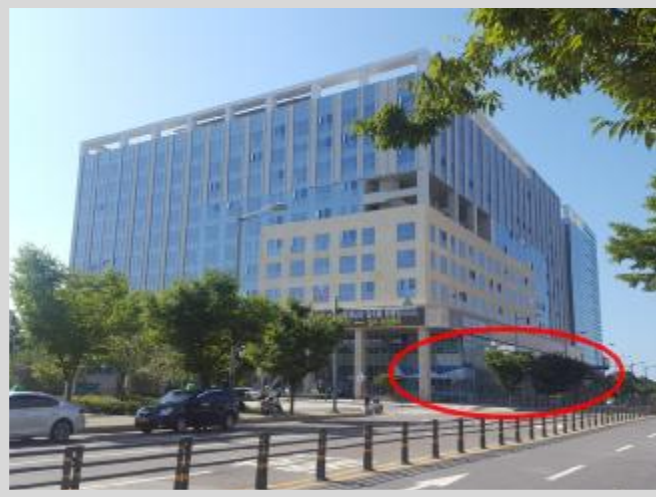
기호(1~4,13,15) 등 1층 북서측 전면 근린생활시설 전경 1
