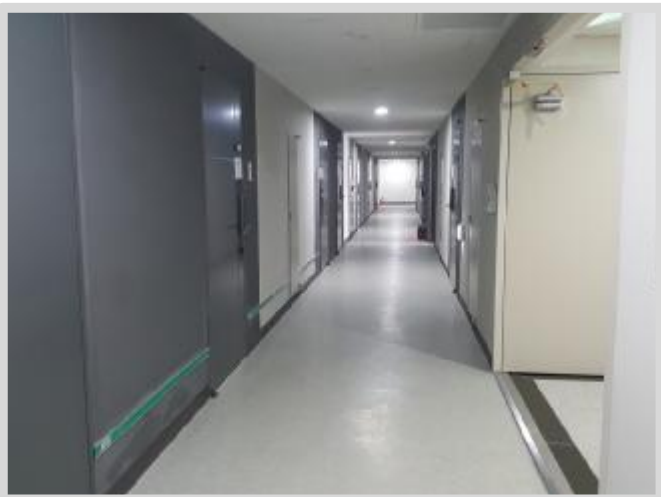
지웰오피스텔 내부 복도 등 전경 1
